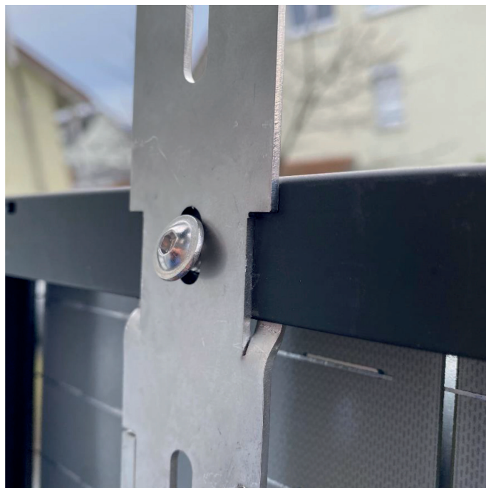
Locker angesetzte Schraube M6 kurz.
