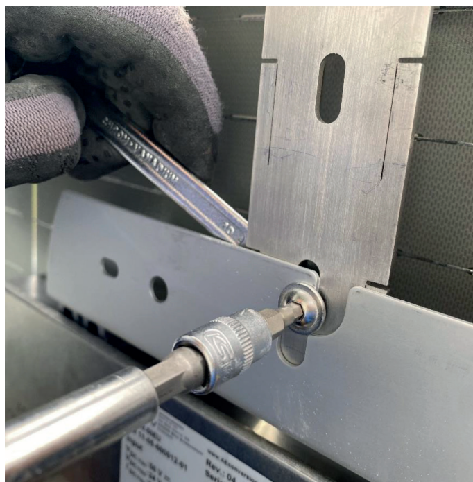
Wechselrichter am SOLAR-HOOK Befestigungsbügel anschrauben
