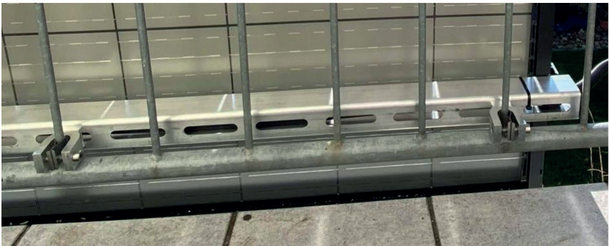
Montageschiene an Spezialklemme
