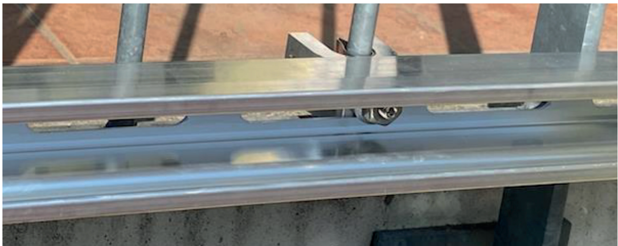
Montageschiene und Spezialklemme von außen
