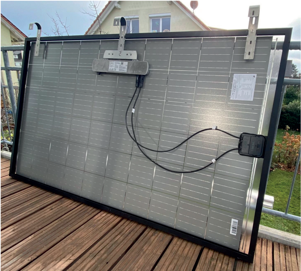
Vorbereitetes Solarmodul mit 3 Befestigungsbügel und Wechselrichter
